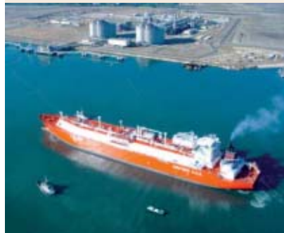
The largest LNG plant, Damietta.
