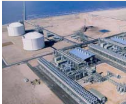
Idku LNG plant.
